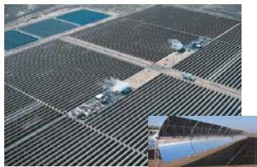
ANDASOL (スペイン:トラフ型・50MW)
