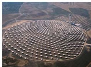
PS10 (スペイン:塔ワ-型・11MW)
