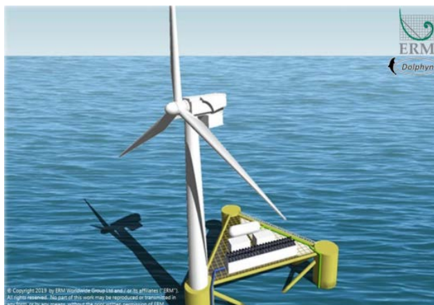
図1 浮体式洋上風力水素製造プラットフォームのデザイン
