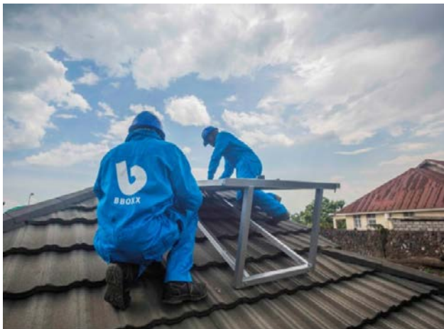
図3-9 屋根へのソーラーパネル据付の様子
