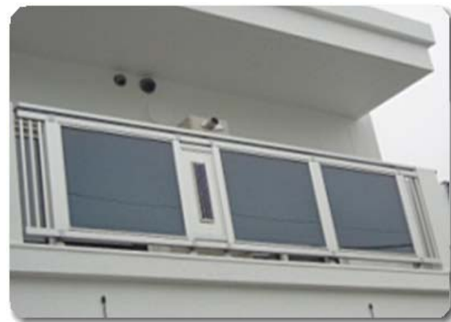
強制循環型太陽熱利用ガス温水システム (SOLAMO)
