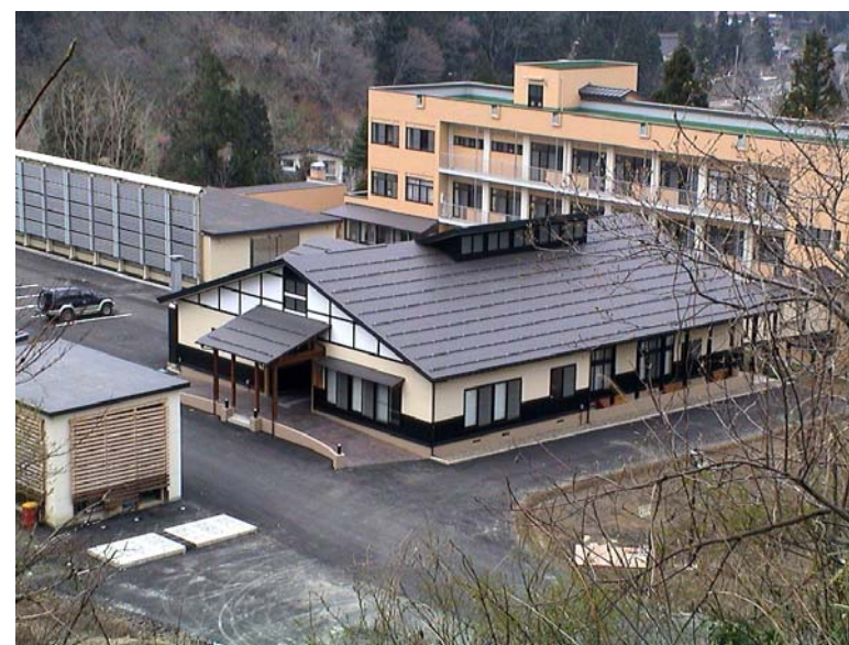
平成13年度に敷地条件よりRC構造による耐雪型貯雪庫を設置
