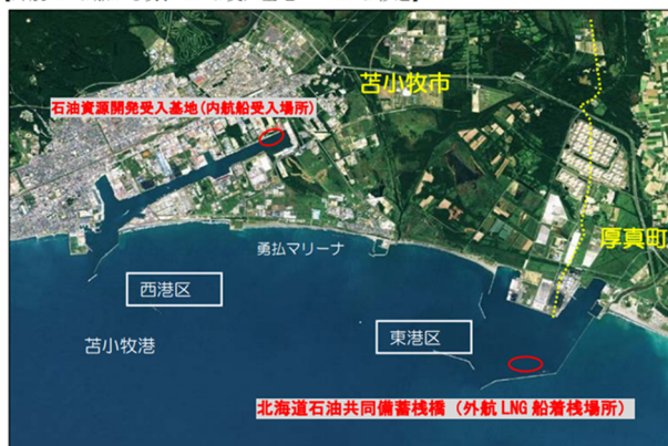
【外航 LNG 船から勇払 LNG 受入基地への LNG 移送】
