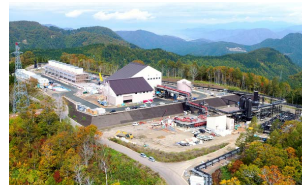
＜秋田・山葵沢（わさびさわ）地熱発電所＞ ※2019年5月に運転開始。国内で23年ぶりとなる新規の大規模地熱発電所。
