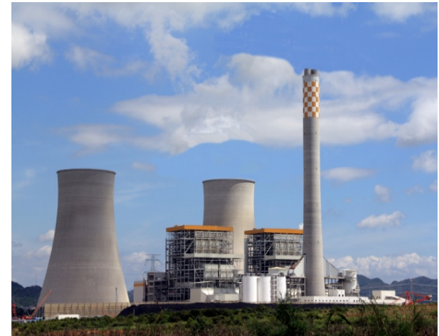
写真: 華潤賀州発電所
