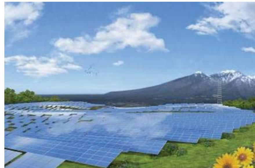
北杜サイト(2MW)
