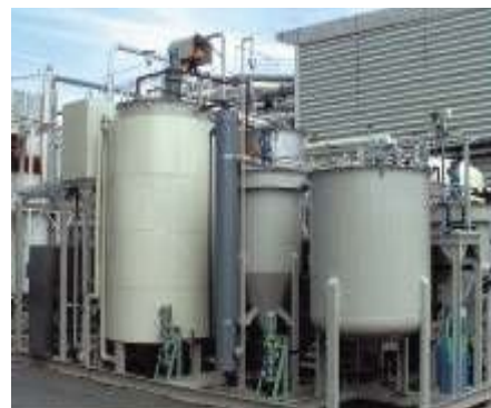
バイオガス化設備
