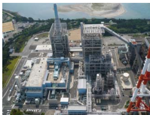
図 3-6 IGCC 実証プラント (勿来)
