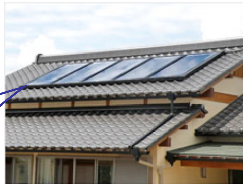
強制循環式太陽熱温水システム
