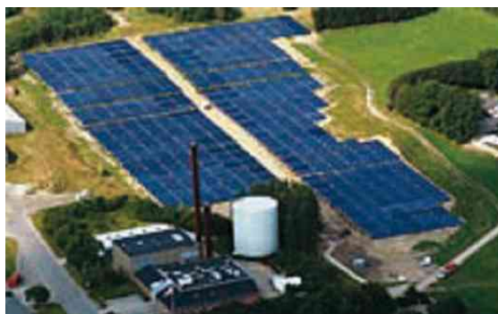
図3.2.1 太陽熱プラント（デンマーク）
