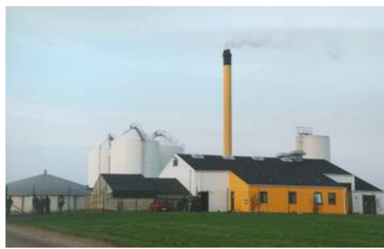
地域暖房熱源としてのバイオガスプラント (デンマーク)
