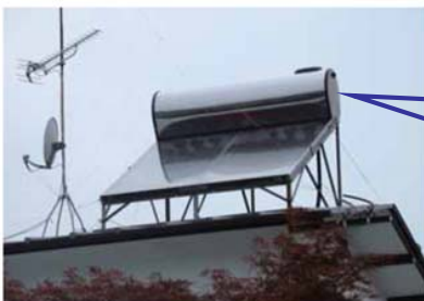
自然循環式太陽熱温水器
