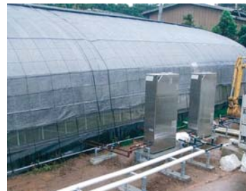
グリーンハウス(九州電力/九州大学)
