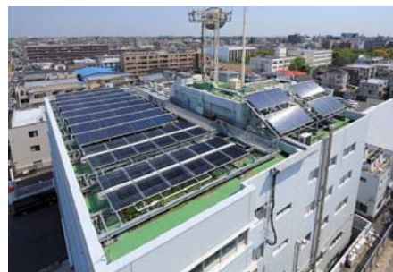
ソーラークーリングシステムの実証試験 (東京ガス 中原事務所)
