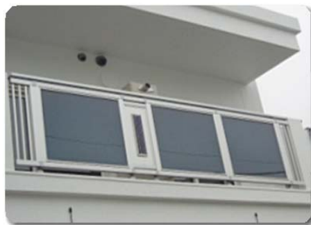
強制循環型太陽熱利用ガス温水システム (SOLAMO)
