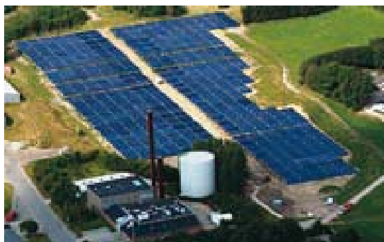
図3. 2. 1 太陽熱プラント（デンマーク）
