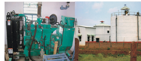
酪農場における バイオガス発電所
